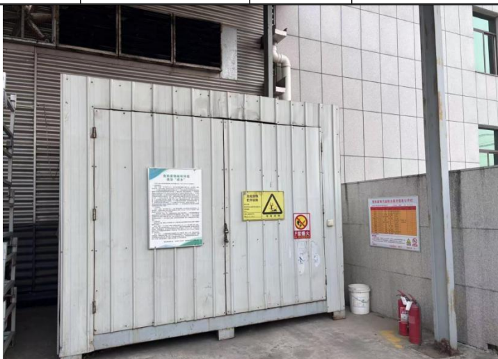
危险废物暂存库
