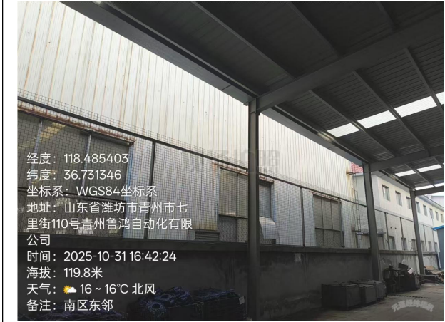
南厂区东厂界
