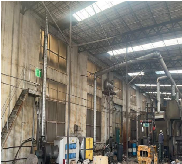
集气罩+油烟净化器+活性炭吸附+15 米排气筒 DA001
