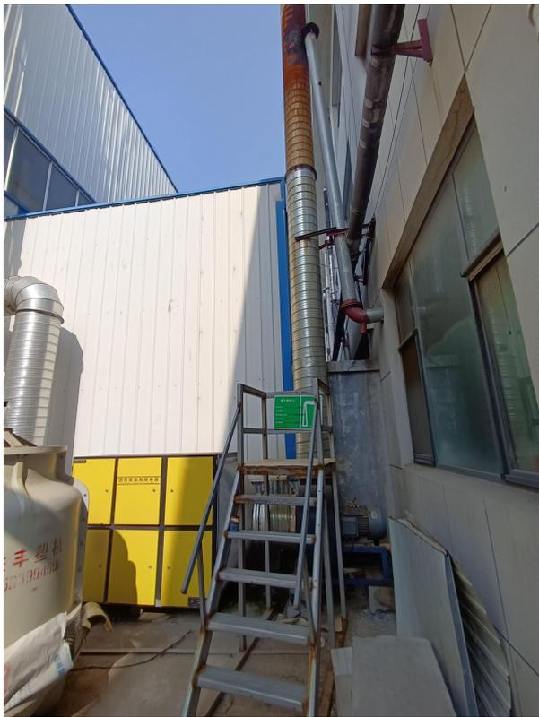
DA001 发酵废气排气筒、发酵车间活性炭吸附箱
